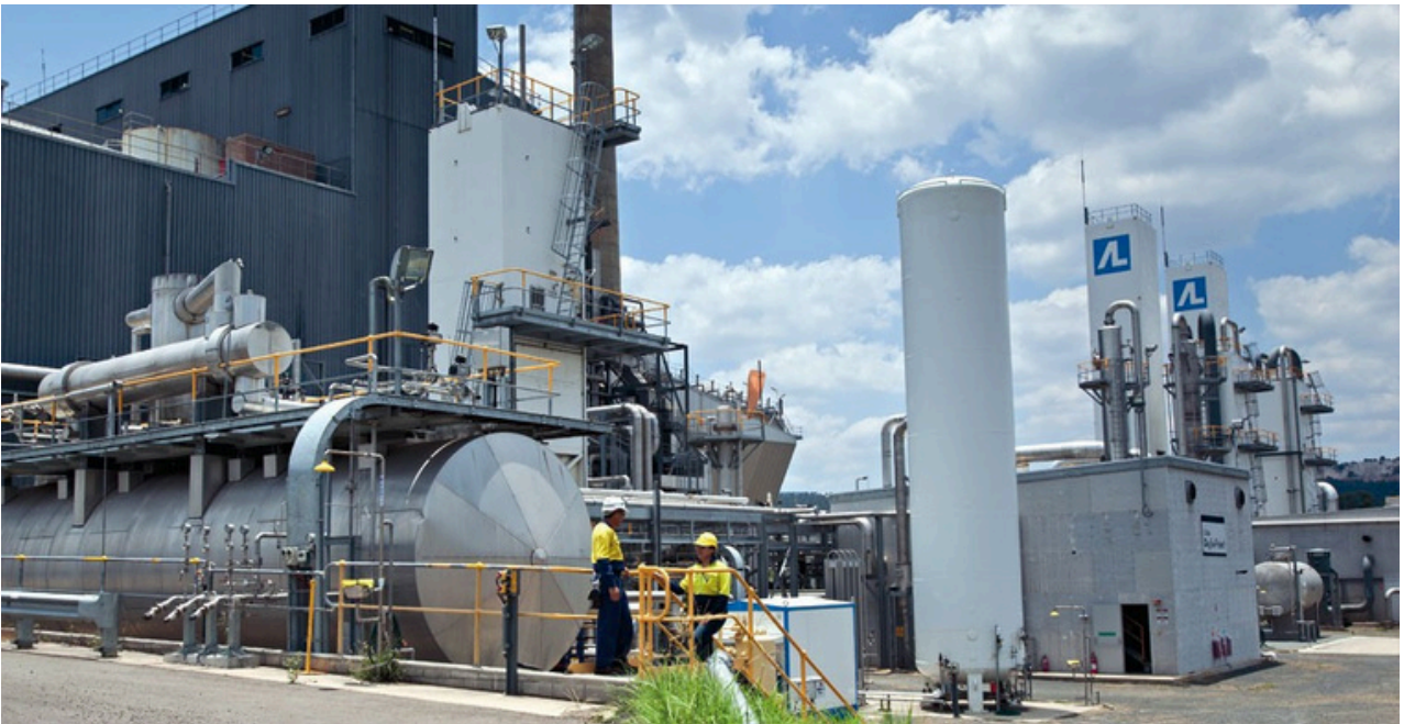
โครงการที่ใช้การดักจับคาร์บอนด้วยการเผาไหม้โดยการใช้ออกซิเจนเพียงอย่างเดียวเพื่อลดการปล่อยก๊าซเรือนกระจก ชื่อโครงการ Callide Oxyfuel Project ที่ประเทศออสเตรเลีย ที่มา: https://esdnews.com.au/callide-oxyfuel-project-throwing-coal-a-lifeline/
