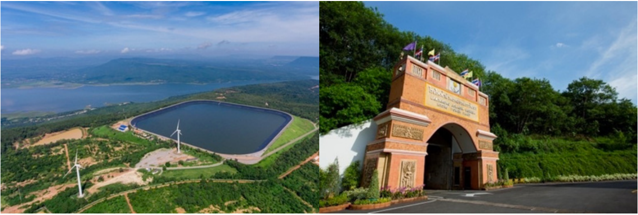
โรงไฟฟ้าพลังน้ำแบบสูบกลับ โรงไฟฟ้าลำตะคองชลภาวัฒนา จ.นครราชสีมา
