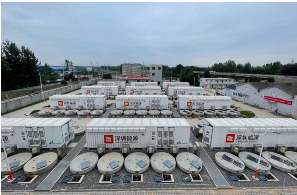
ระบบกักเก็บพลังงานแบบฟลายวีล เขตมณฑลซานซีประเทศจีน
