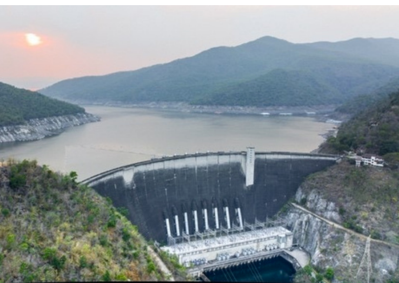
โรงไฟฟ้าพลังน้ำแบบสูบกลับ เขื่อนภูมิพล จ.ตาก
