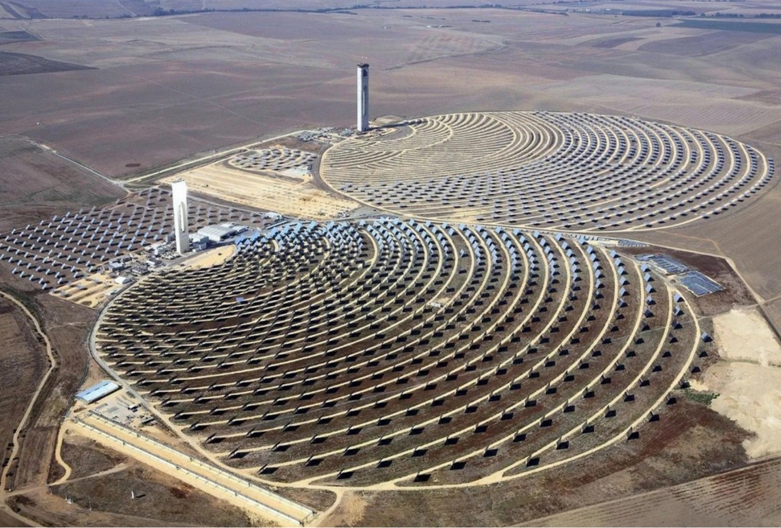
โรงไฟฟ้าพลังความร้อนจากแสงอาทิตย์ระบบหอคอยรวมแสงที่ใหญ่ที่สุดในโลกปัจจุบันตั้งอยู่ที่ประเทศสเปน ที่มา : http://en.wikipedia.org/wiki/PS20_solar_power_plant
