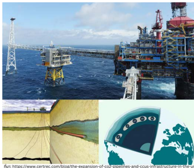
แหล่งกักเก็บคาร์บอนไดออกไซด์ Sleipner ประเทศนอร์เวย์
