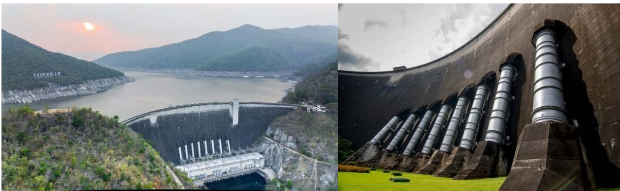
โรงไฟฟ้าพลังน้ำแบบสูบกลับ เขื่อนภูมิพล จ.ตาก
